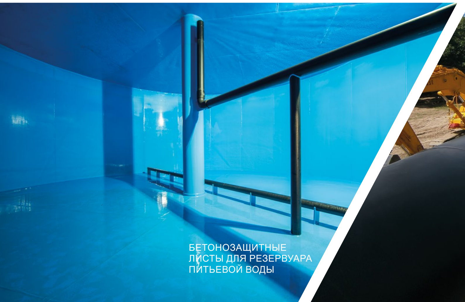
УСТАНОВКА ДЛЯ ЧИСТОЙ ВОДЫ
