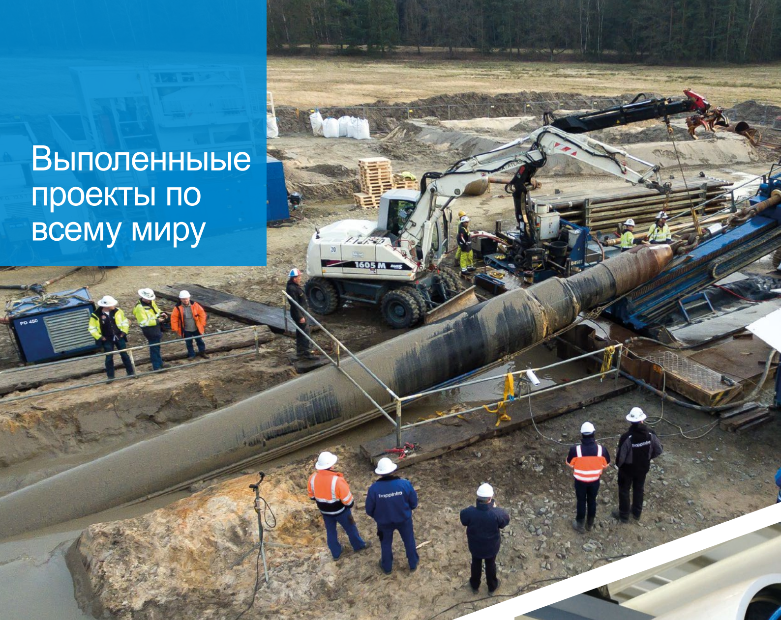
САМОЕ БОЛЬШОЕ В МИРЕ ГИДРАВЛИЧЕСКОЕ БУРЕНИЕ Ø1400MM
