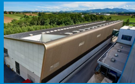
2019 РАСШИРЕНИЕ ЗАВОДА С ЧИСТЫМИ ПОМЕЩЕНИЯМИ
